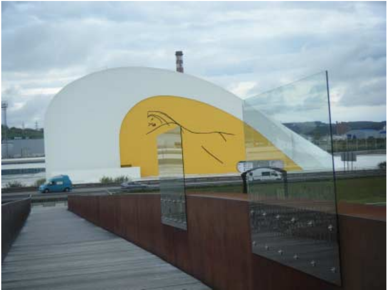
Figura 2. El Centro Cultural Avilés. Obra de Oscar Niemeyer.
