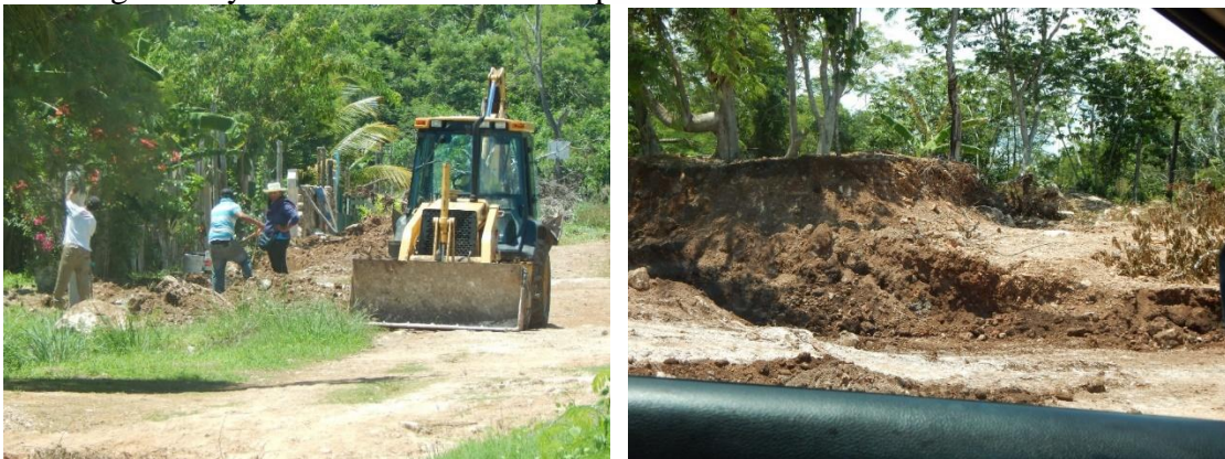
Imágenes 4 y 5. Proceso de desmonte para la conformación de un asentamiento
